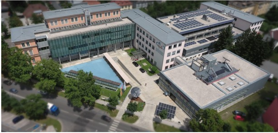
Große Teile des Schuldachs sind bereits mit hocheffizienten Solarpanelen ausgestattet
