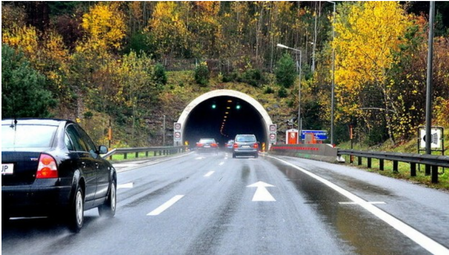
Der Falkenbergtunnel(Bild: Asfinag)
