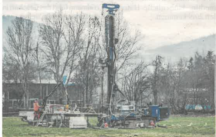
Bodenuntersuchungen am Grundstück bei Minimundus WEICHEL/BRAUN
